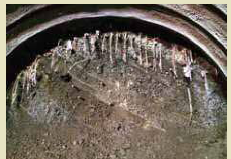
盛土区間の切羽状況
