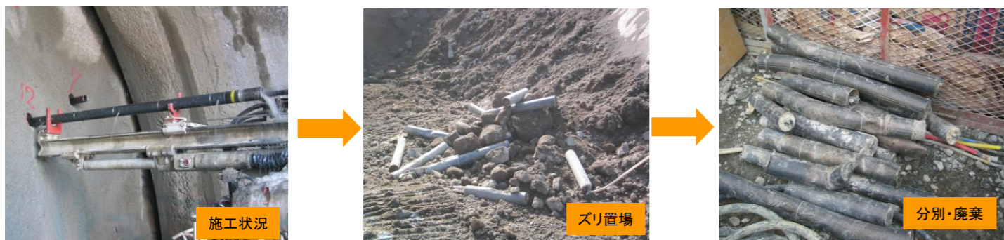
※掘削で発生した鋼管(土砂との分別も容易です)
